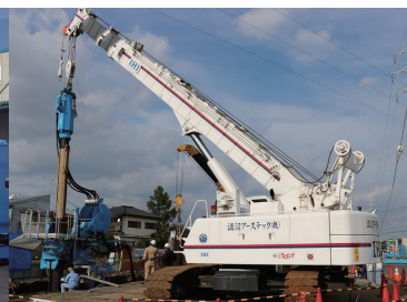
上空線下での圧入作業
