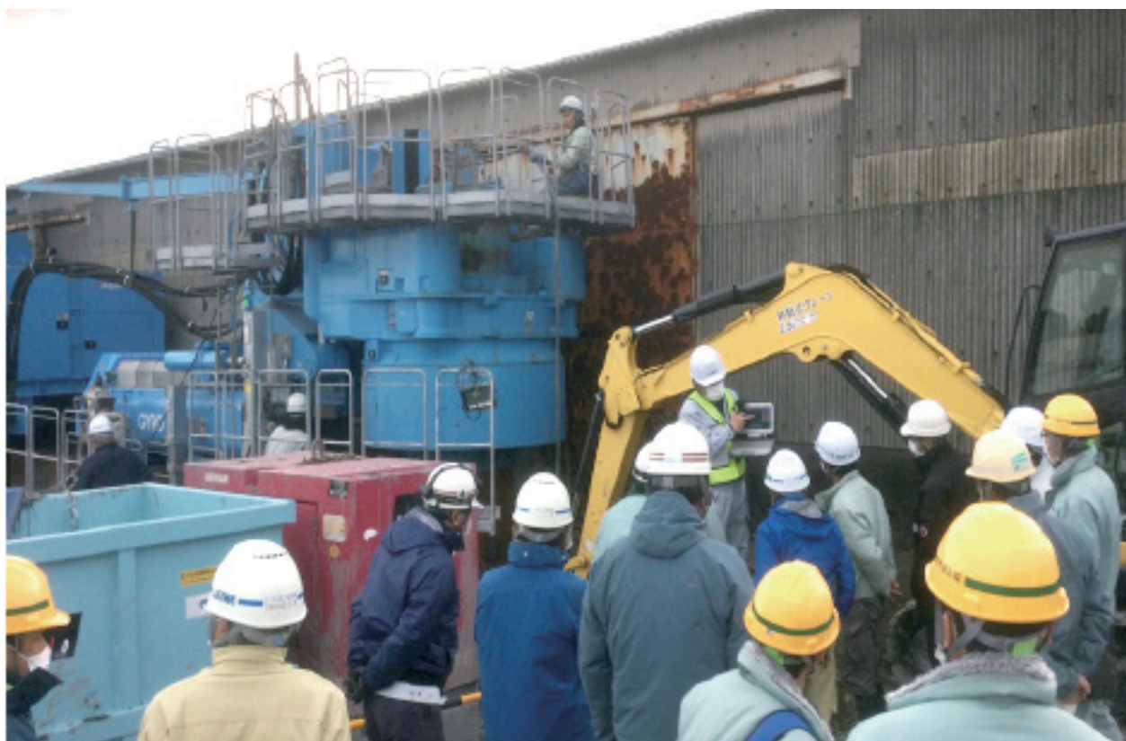
パソコンを用いて施工状況を説明
