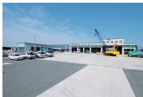
工場構内の様子
