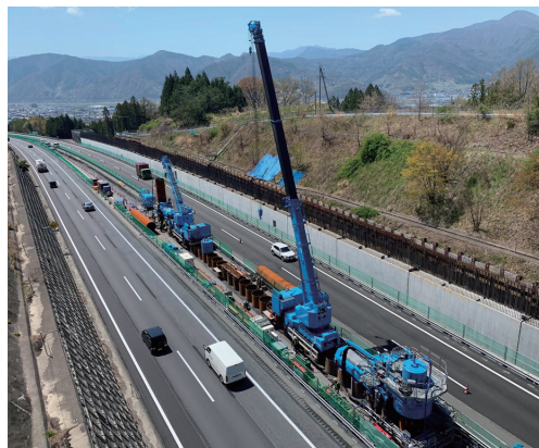
供用中高速道路におけるジャイロプレス2台施工
