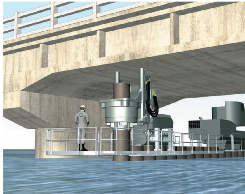
桁下施工など空頭制限のある場所でも、コンパクトな施工機械と完成杭の天端近くで圧入杭をつかむ原理により施工が可能です。特に高さ制限が厳しい場合は、機械寸法を徹底的に圧縮した低空頭対応機を選択することができます。
