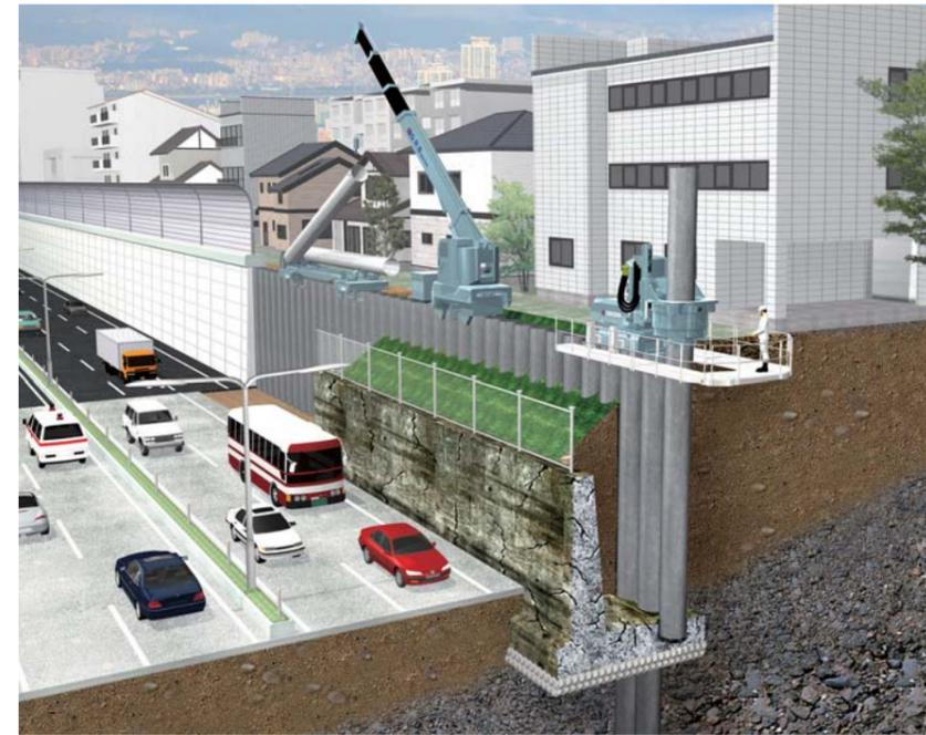
鋼管杭を壁状に連続的に施工し、杭間に継手材を挿入することにより、擁壁構造が容易に構築できます。鋼管杭上をクランプクレーンなど各種施工機械が自走するGRBシステム施工によって、都市部の狭隘な場所でも、現況交通や周辺環境に影響を与えず都市機能を進化させることができます。
