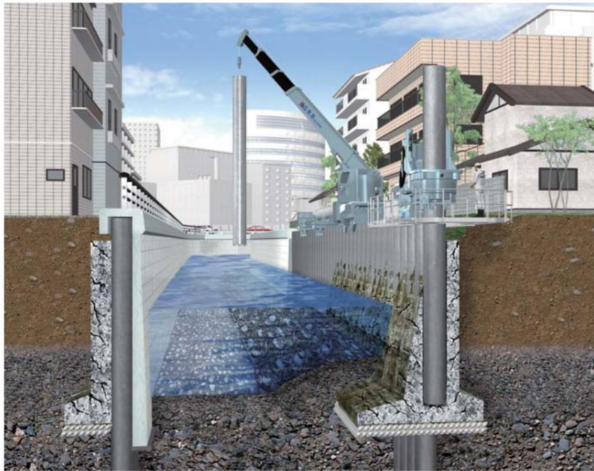
工事の難易度の高い住宅密集地での洪水対策や地震対策の護岸改修工事においても、既設構造物を貫通させるジャイロプレス工法なら、現況河川の河積や水上交通の航路を阻害することなく、強靱な護岸壁を急速施工できます。
