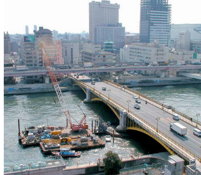
橋脚基礎耐震補強工事
