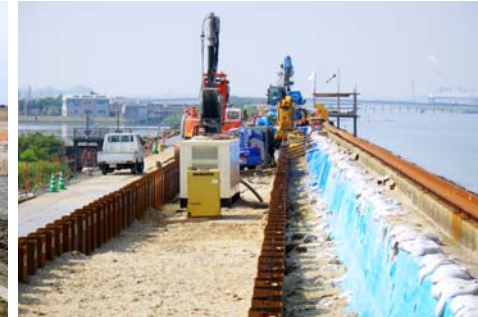
(株)梶川建設施工
