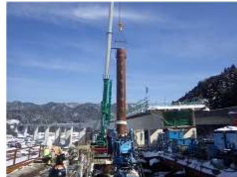
▲中西高架橋工事 施工中の様子
