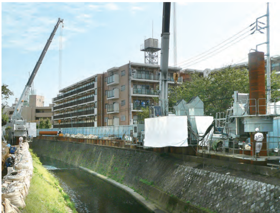
ジャイロプレス工法による住宅地での河川護岸整備工事
