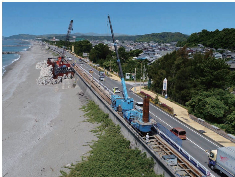
ジャイロプレス工法™による高知海岸での海岸堤防改良工事
