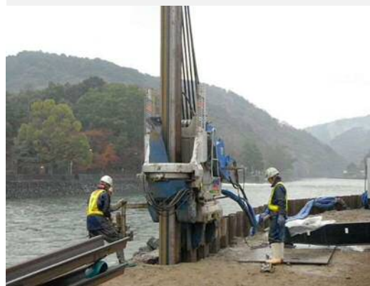
環境を守る硬質地盤クリア工法が活躍
