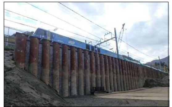
超硬質地盤をクリアし見事に完工
